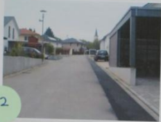
12 Autos fahren langsam
