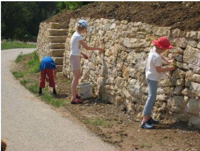
Abbildung 27: Arbeitseinsatz an der Trockenmauer. 33
