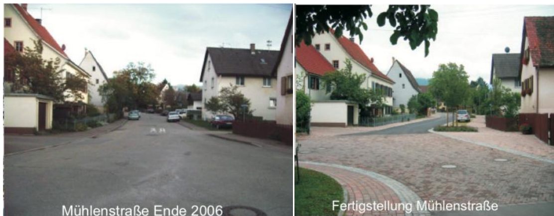
Abbildung 15: Vorher und Nachher: Sanierung der Mühlenstraße. 8
